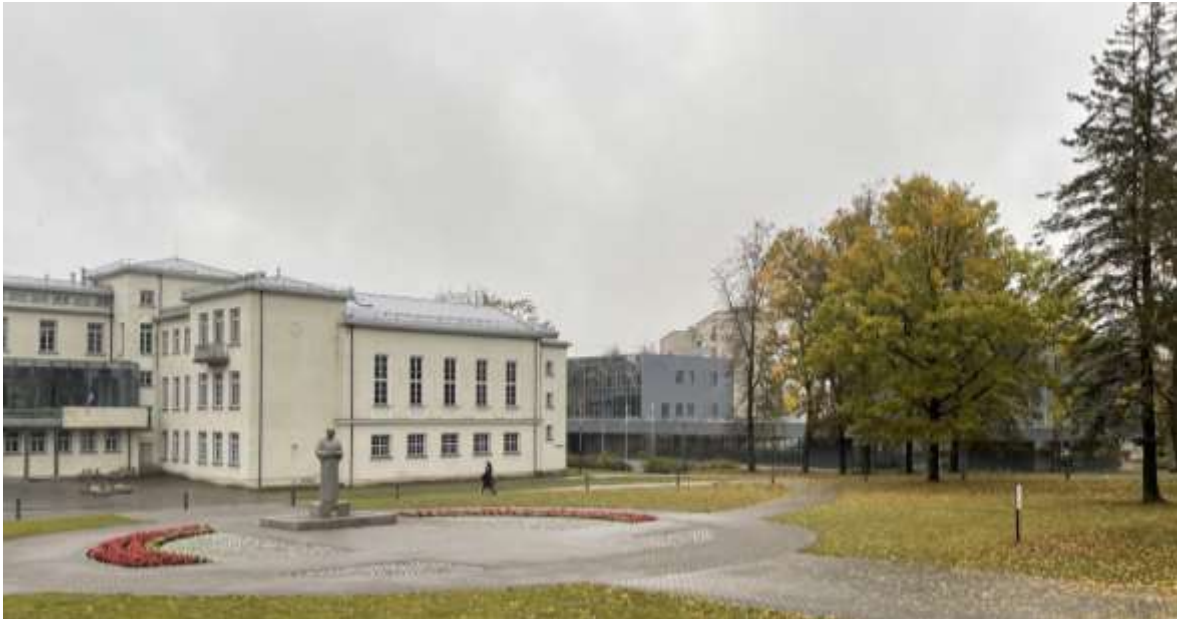
Hauptgebäude und Ingenieurgebäude (grau) der RTA
