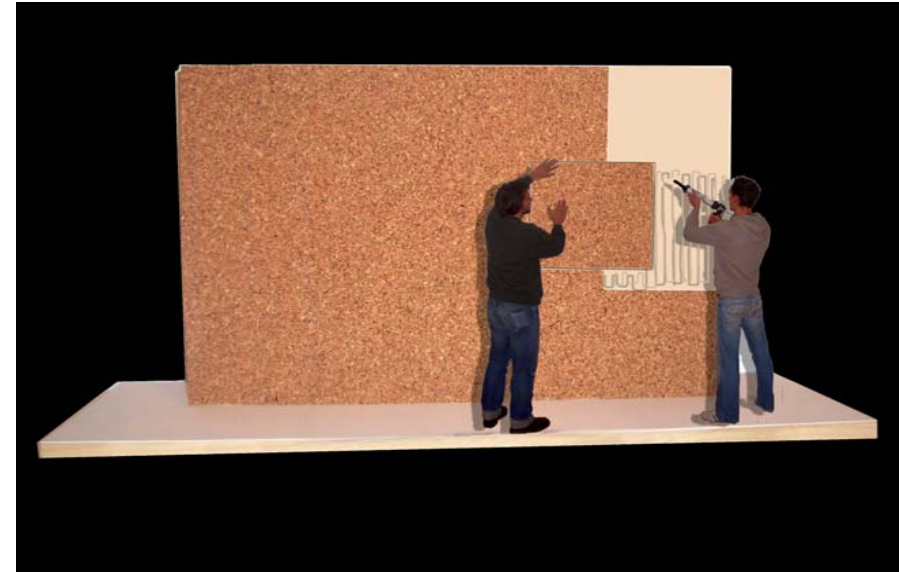
2. Auf die Trägerplatte werden Korkplatten geklebt.
