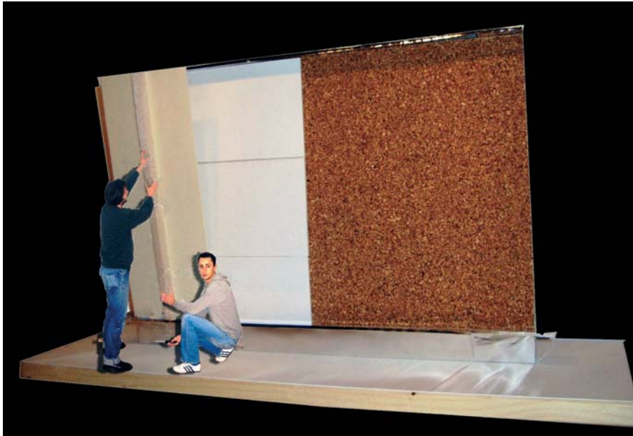
5. Die Vakuum-Isolationspaneele werden mit Leimschichtholzplatten verkleidet, auf denen jeweils bereits ein tragender Hauptpfosten befestigt ist.
