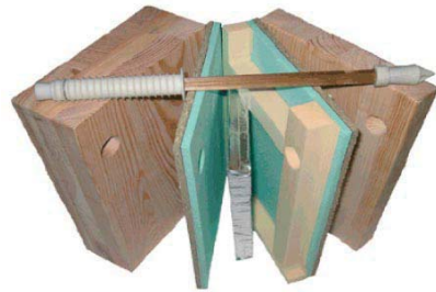
VIP in PUR geschützt Glasfaseranker leiten statische Lasten ab
