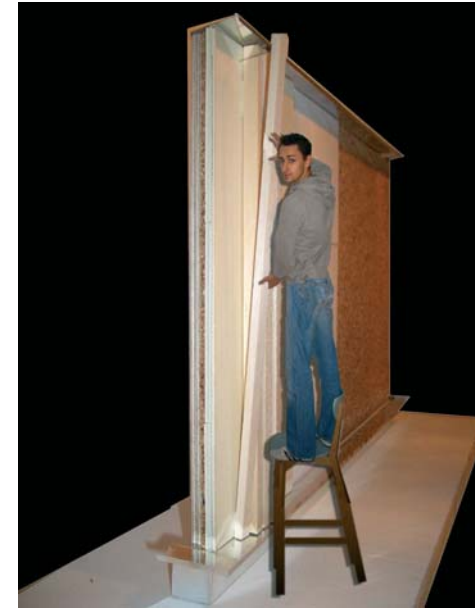
6. Zwischen diese Hauptpfosten werden Füllpfosten geklemmt.
