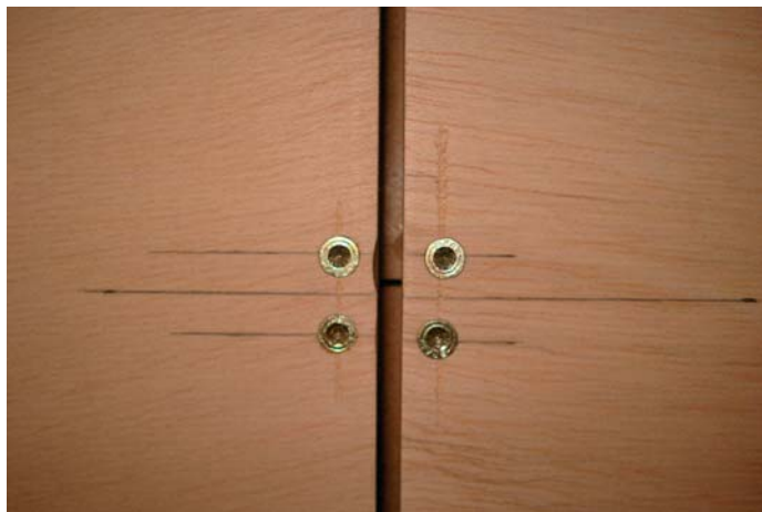
Befestigung der 2. Lage an den Elementen der 1. Lage
