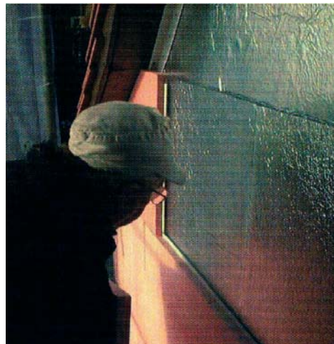
... während der Montage. Die VIP werden stumpf (mit minimaler Fuge) gestoßen.
