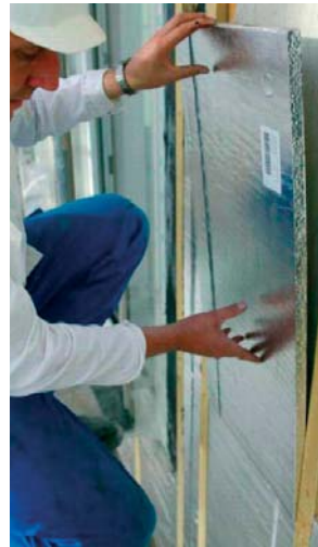
Montage der VIP zwischen den PUR-Leisten
