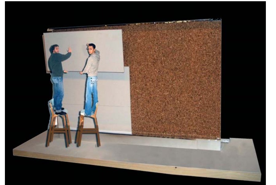
4. Montage der Vakuum-Isolationspaneele
