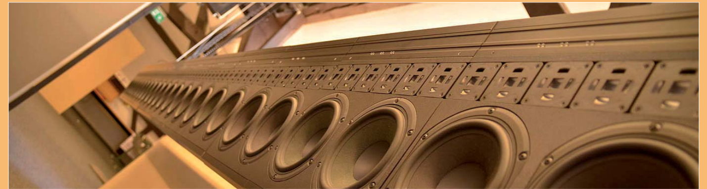
An den Trägern werden 52 Panels mit je 8 Lautsprechern befestigt.
