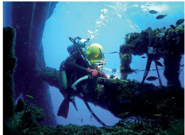
Unterwasser-Schweißer bei Reparaturarbeiten
