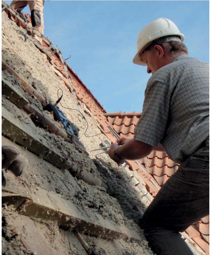
Überprüfung der Materialfeuchten an einer freigelegten Dachkonstruktion
