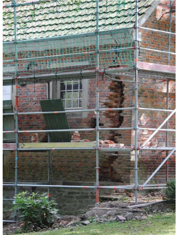
Sanierung der Risse im Außenmauerwerk
