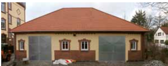
Außenansicht des Labors für Messtechnik
