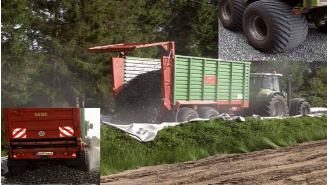
Anlieferung des Schaumglasschotters für den Bau der Teststrecke
