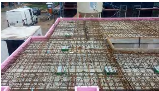
Geschossdecken (ohne Fußbodenaufbau)
