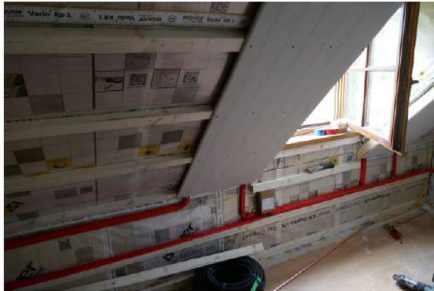
Fertig montierte Konterlattung über der Dampfbremssfolie der Dachdämmung aus Mineralwolle geschraubte Deckenheizungsplatten mit eingelassenen Kupferleitungen.
