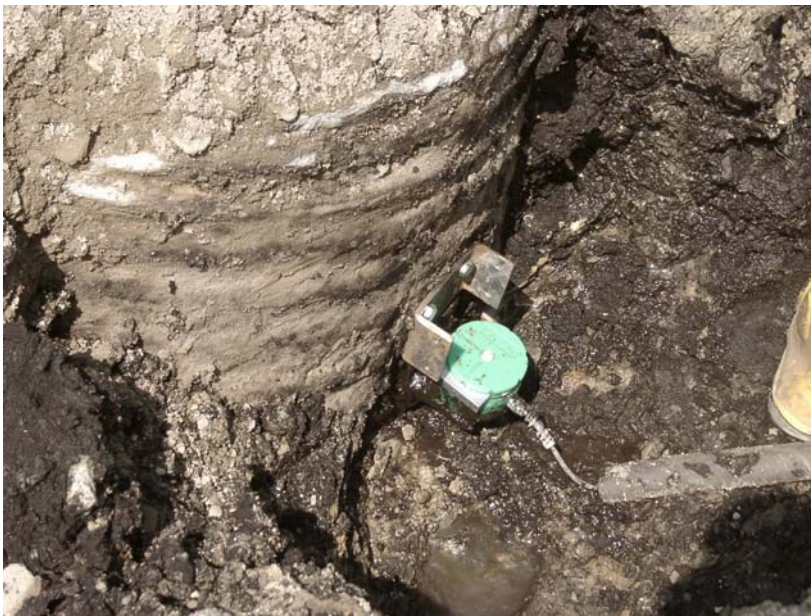
Bild 3: Ankopplung des VMS- Messgebers an eine Betonsäule
