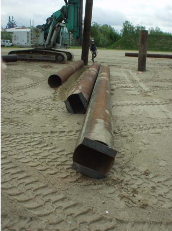
Bild 1: teilverschlossene Stahlrohrpfähle
