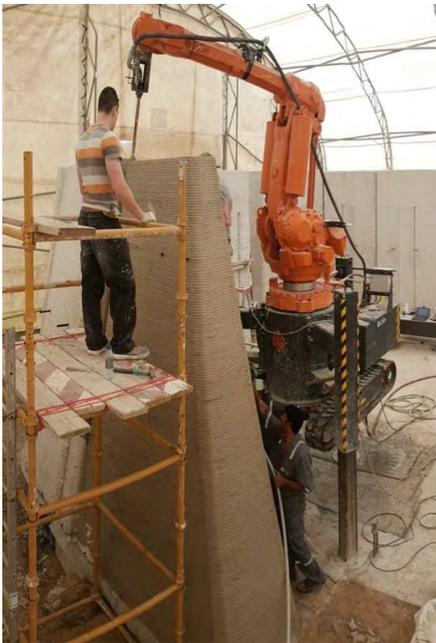
**Abb. 7: CyBe RC 3D Betondrucker**
