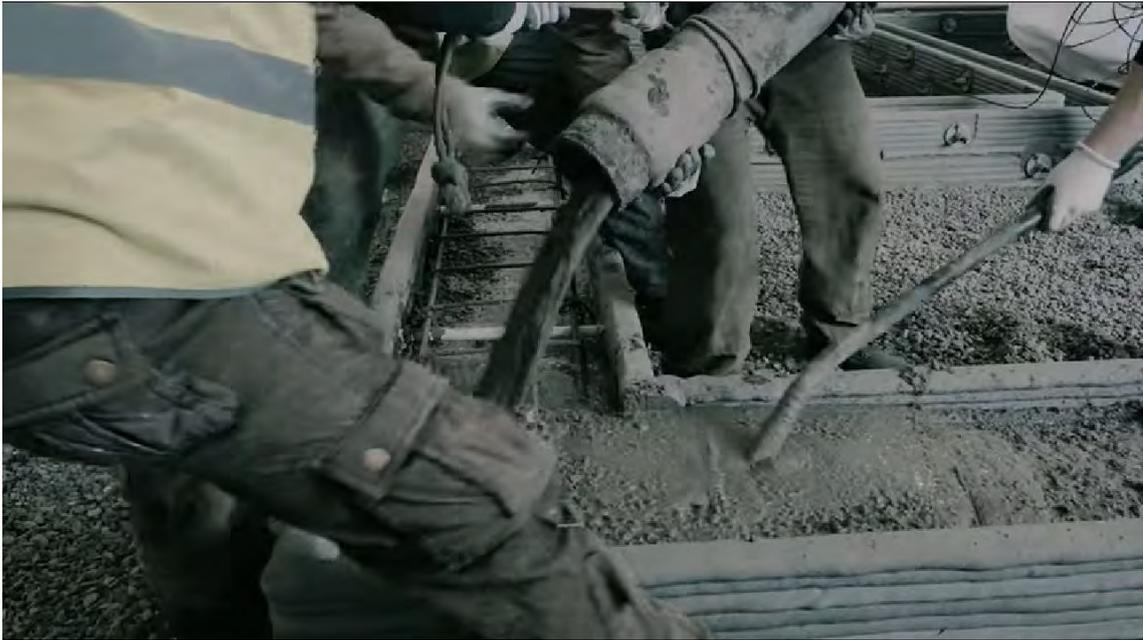
**Abb. 22: Verfüllung der Streifenfundamente**
