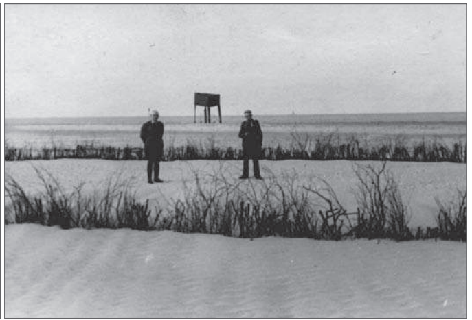
Buschzäune im Norden (Hochdünkirchen) zur Erhöhung der Düne. Fotos: Harms
