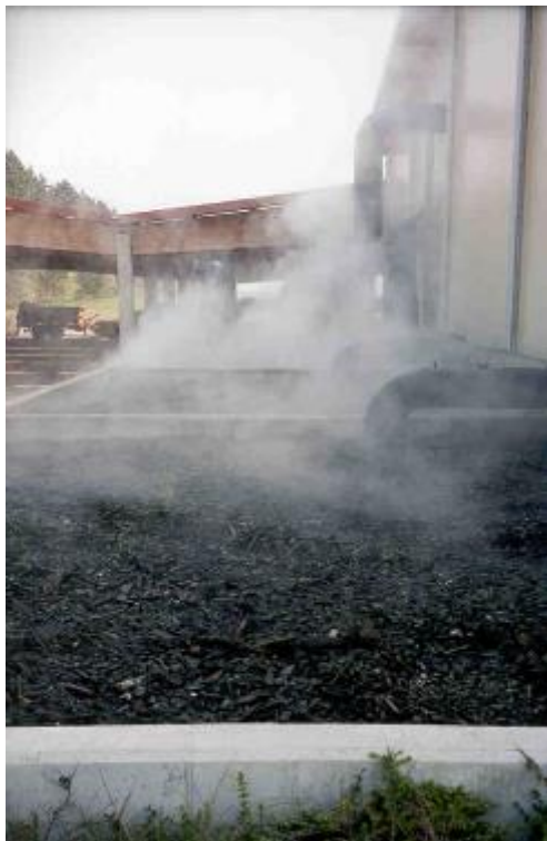
Biofilter an der Kompostierungsanlage in Ingolstadt
