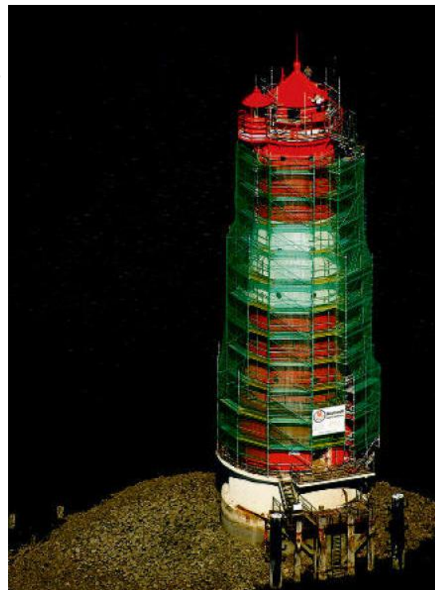
Gerüstbau-Unternehmen Nietiedt im Einsatz. Foto: Nietiedt
