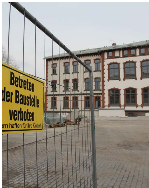
Baustelle auf dem neuen „Ansgari Campus“. Foto: J.Glose
