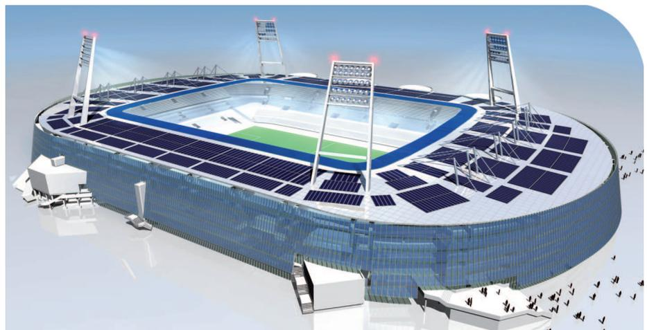
Werder plant mit Photovoltaik: Rund 200.000 Solarzellen auf dem Glasdach des Stadions sollen künftig den benötigten Strom produzieren.
