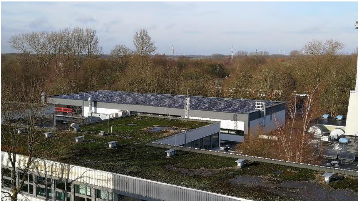
**Abbildung 1: PV-Anlage Maschinenhalle 1-4, Leistung 71,28 kWp**
