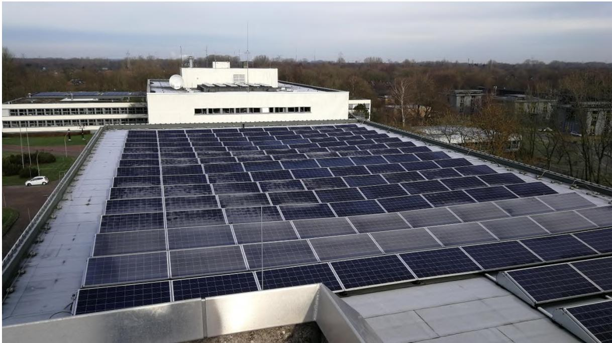
**Abbildung 3: PV-Anlage Südgebäude, Leistung 70,20 kWp**
