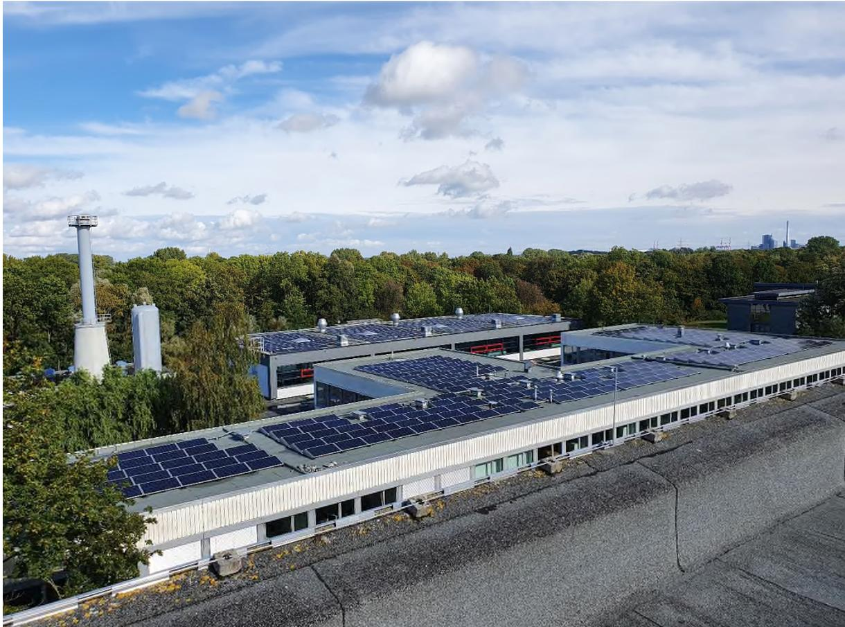
**Abbildung 7: PV-Anlage Laborgebäude, Leistung 140 kWp**
