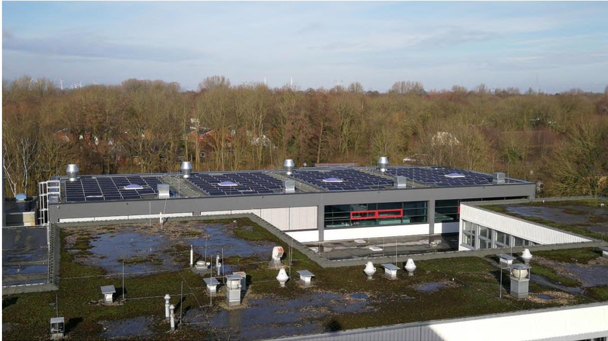
**Abbildung 2: PV-Anlage Maschinenhalle 5-8, Leistung 57,51 kWp**
